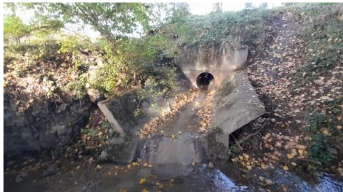
Relevé diagnostic - rejet au cours d'eau
